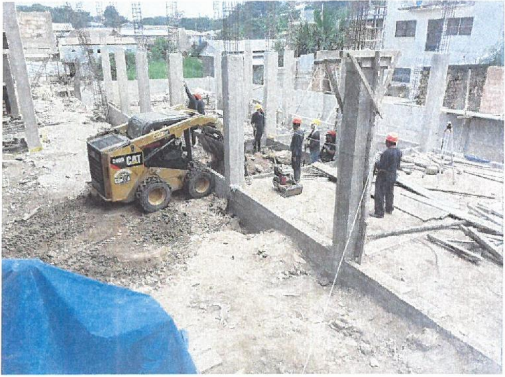
EN LA FIGURA SE MUESTRA LA PARTIDA DE RELLENO Y COMPACTACION CON MATERIAL DE PRESTAMO SELECCIONADO EN EL MODULO .
