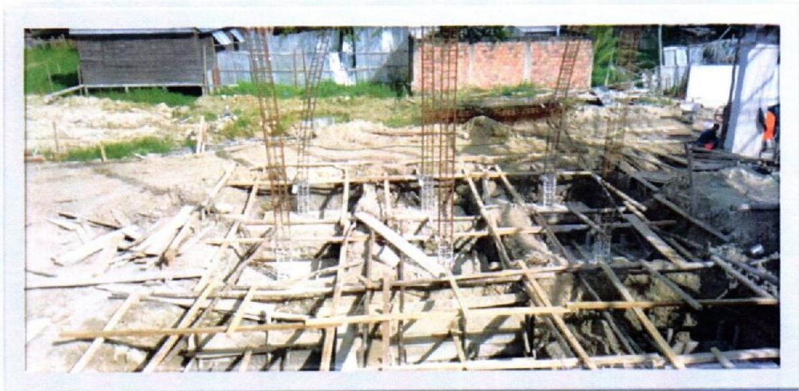
Vista panorámica de los trabajos de construcción en la zona de SS.HH de varones y mujeres
