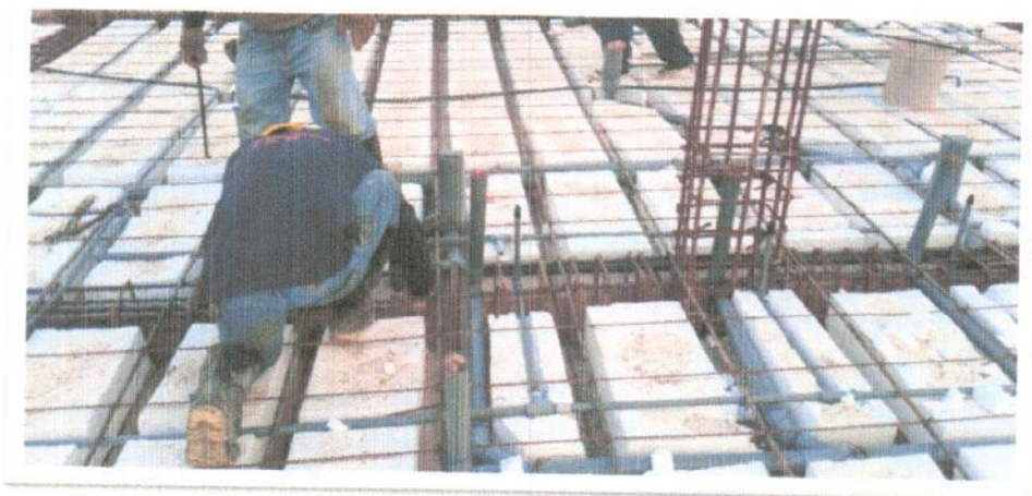
Instalaciones sanitarias en muro de contención
