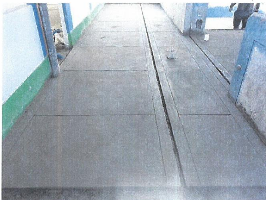
EN LA FIGURA SE OBSERVA FROTACHAADO DE PISO EN EL SEGUNDO PISO DEL PABELLON EXISTENTE
