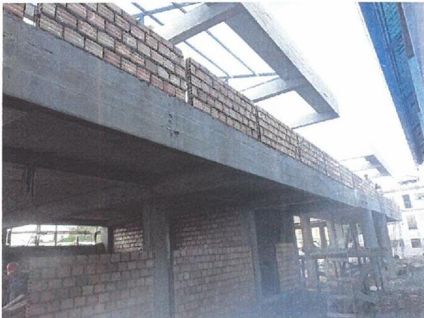
EN LA FIGURA SE MUESTRA ASENTADO DE LADRILLOS DE CANTO EN EL SEGUNDO PISO EN EL MODULO
