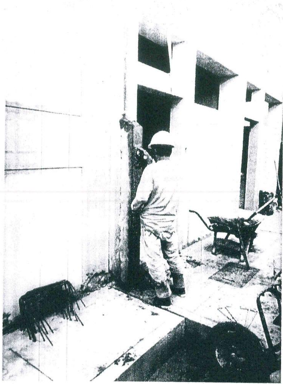
Trabajos en sistema de desagüe pluviales
