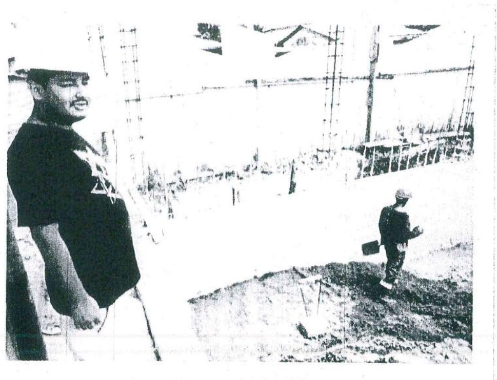
Trabajos de relleno y compactación en zonas paralelas al cerco perimétrico
