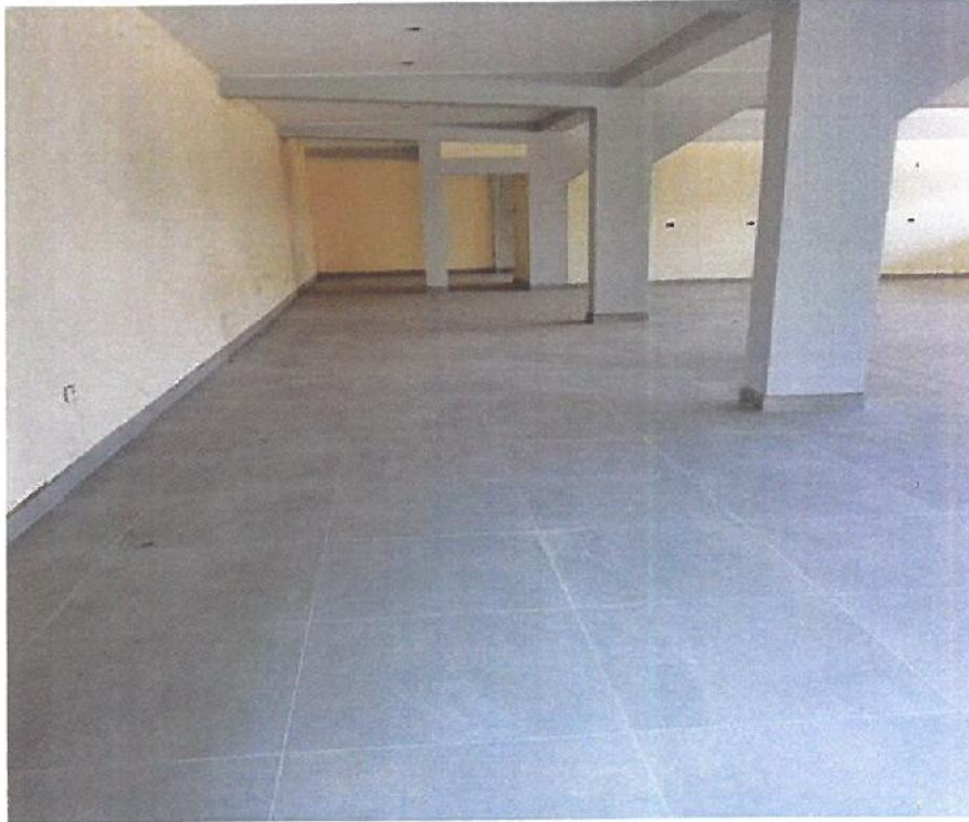
EN LA FIGURA SE OBSERVA EL ENCHAPADO DE PISOS CON PORCELANATO ANTIDESLIZANTE DE 0.60 X 0.60. EN LA ZONA REFACCION
