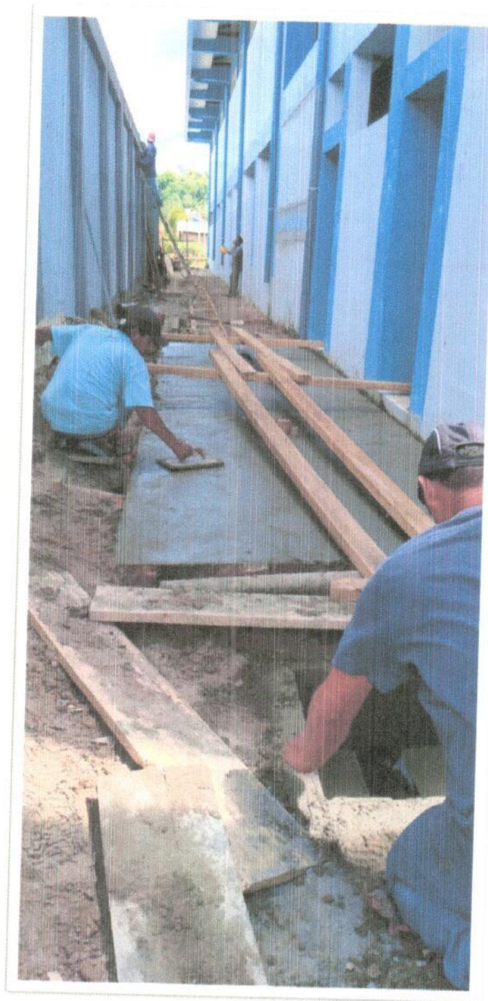
Mortero en vereda de circulación y sistema de drenaje
