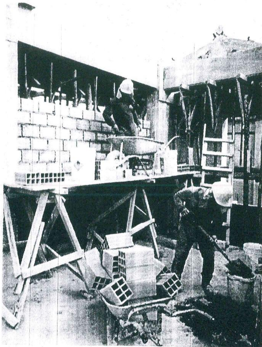
Trabajos de mampostería en muros
