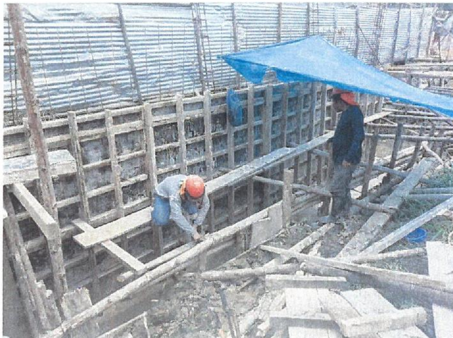
EN LA FIGURA SE MUESTRA LA PARTIDA ENCOFRADO DE MURO DE CONTECION CERCO PERIMETRICO
