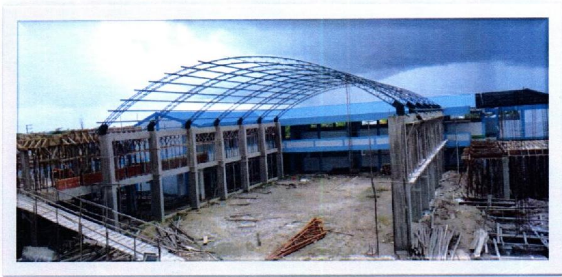
Vista panorámica del hangar con los correajes metálicos terminados
