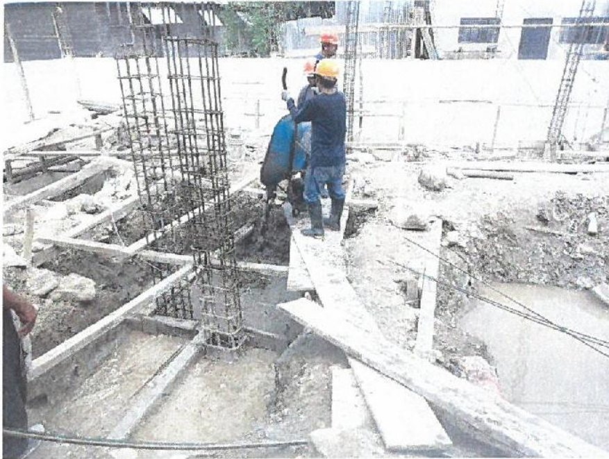
EN LA FIGURA SE MUESTRA VACIADO DE ZAPATAS DEL MODULO .
