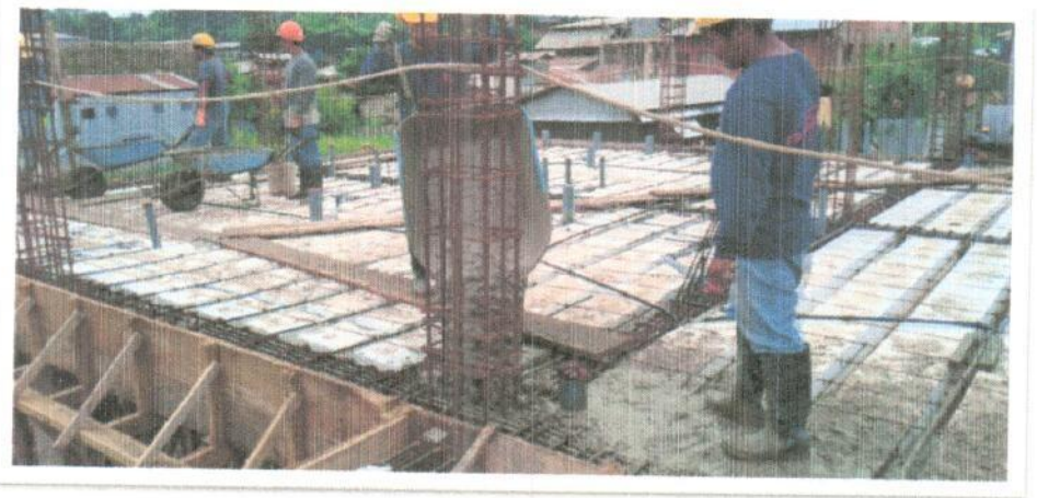
Vaceo de concreto en losa aligerada
