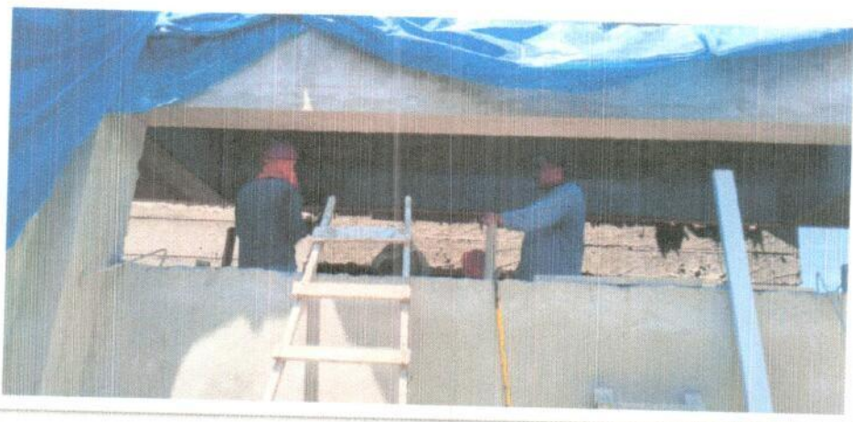
Tarrajeo en vigas y zonas de canaleta de concreto
