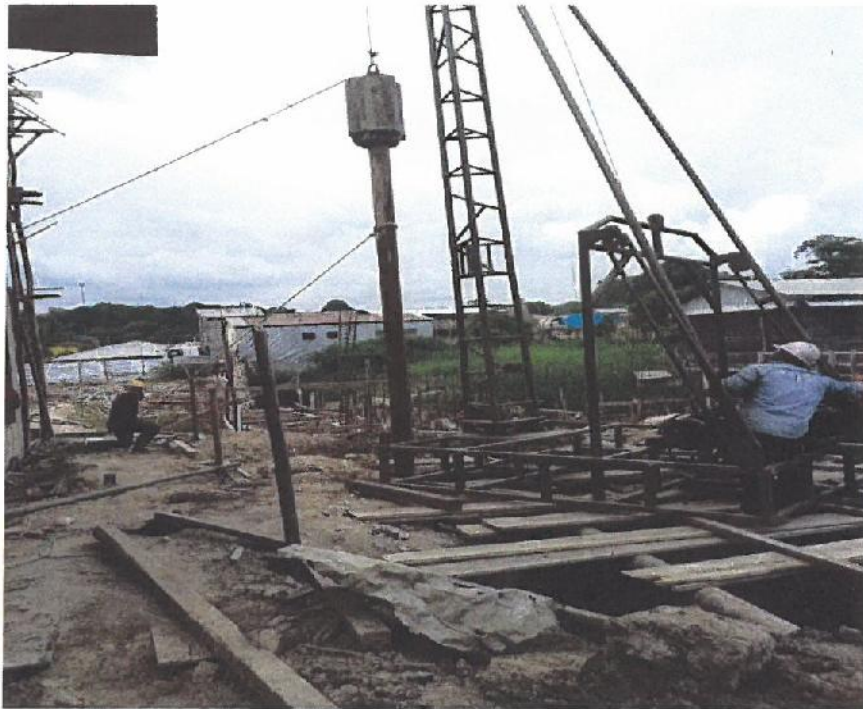
EN LA FIGURA SE MUESTRA LOS TRABAJOS DE HINCADO DE PITOTES 6" EN LA ZONA DE ZAPATAS DEL MODULO E.
