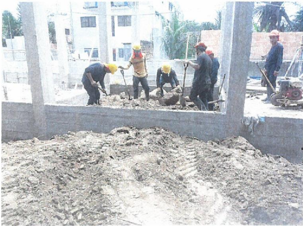
EN LA FIGURA SE MUESTRA LA PARTIDA DE RELLENO CON MATERIAL DE PRESTAMO SELECCIONADO EN EL MODULO .
