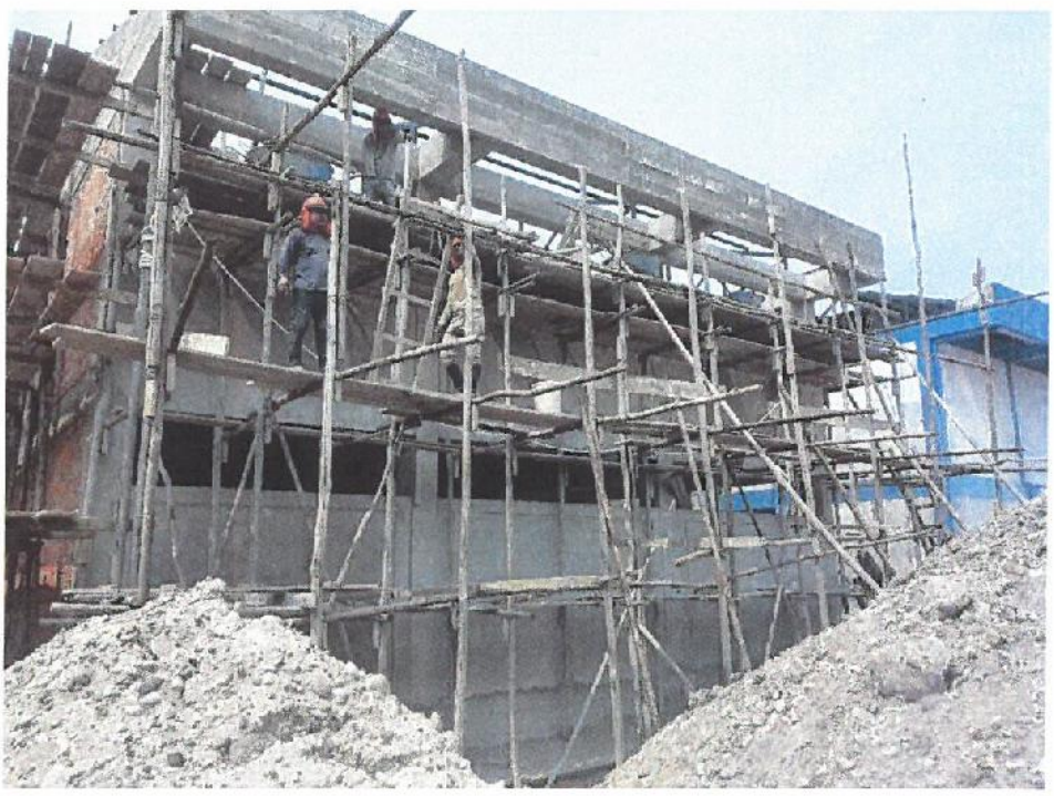
EN LA FIGURA SE MUESTRA LA PARTIDA DE TARRAJEO Y BRUÑADO DE FACHADA DEL MODULO.
