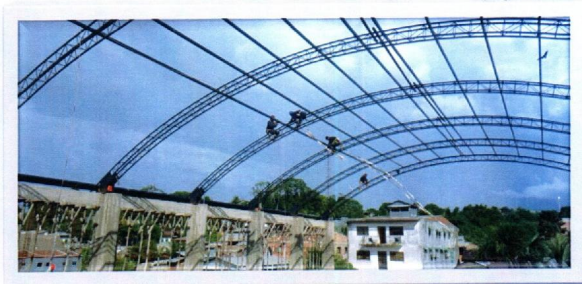
Vista panorámica de los trabajos de colocación de correajes metálicos para el hangar de patio de formación
